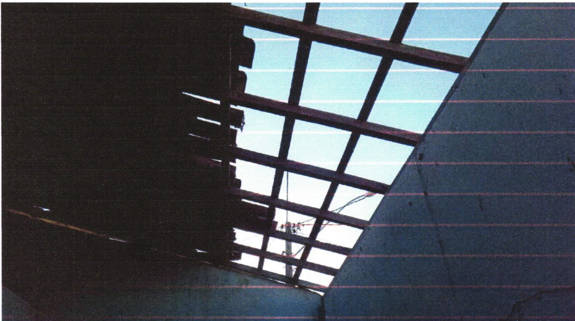
Foto 08 - Remoção de telhamento com telhas cerâmicas
