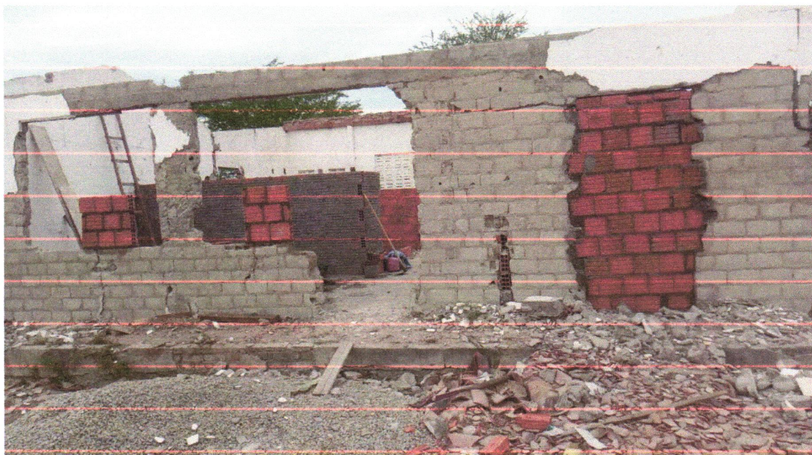
Foto 12 - ALVENARIA DE VEDAÇÃO DE BLOCOS CERÂMICOS FURADOS NA HORIZONTAL DE 9X19X29 CM (ESPESSURA 9 CM) E ARGAMASSA DE ASSENTAMENTO COM PREPARO EM BETONEIRA. AF_12/2021
