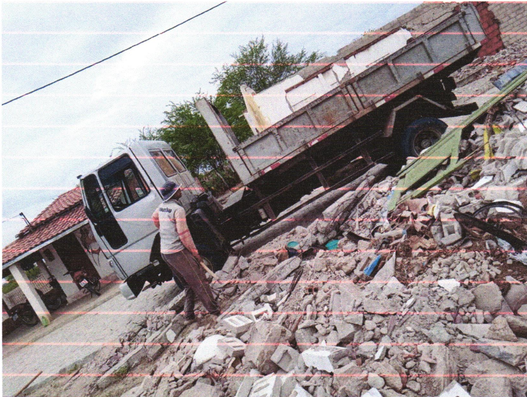
Foto 05- TRANSPORTE COM CAMINHÃO BASCULANTE DE 10 M 3 , EM VIA INTERNA (DENTRO DO CANTEIRO - UNIDADE: M3XKM). AF_07/2020
