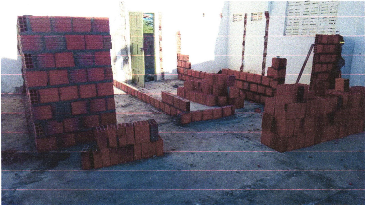
Foto 11 - ALVENARIA DE VEDAÇÃO DE BLOCOS CERÂMICOS FURADOS NA HORIZONTAL DE 9X19X29 CM (ESPESSURA 9 CM) E ARGAMASSA DE ASSENTAMENTO COM PREPARO EM BETONEIRA. AF_12/2021
