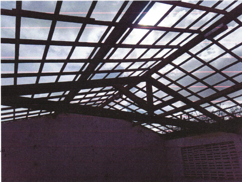
Foto 07 - Remoção de telhamento com telhas cerâmicas
